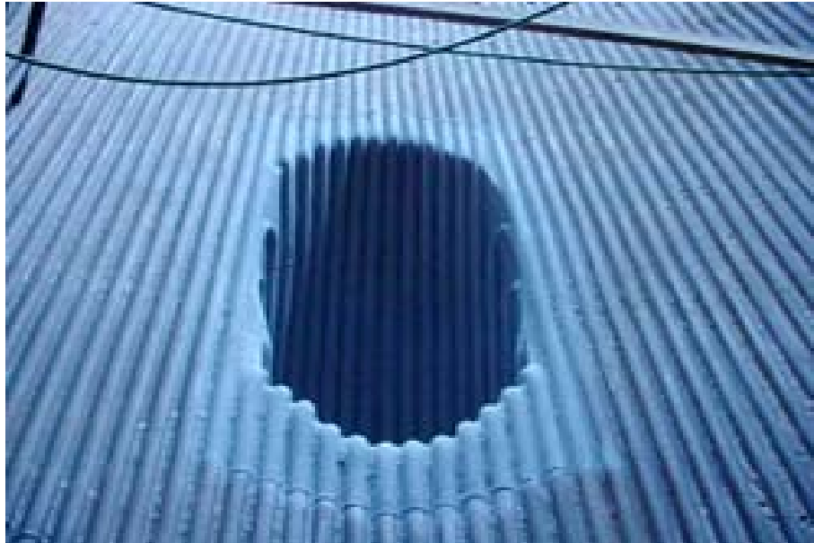
Figura 2.29 – Tubulação “niobizada” pela tinta criada na Coppe/UFRJ. O equipamento, instalado em uma indústria química, atua como trocador de calor [93].
